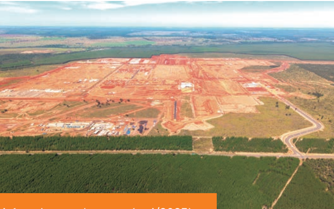
A fase de terraplenagem (mai/2025)
