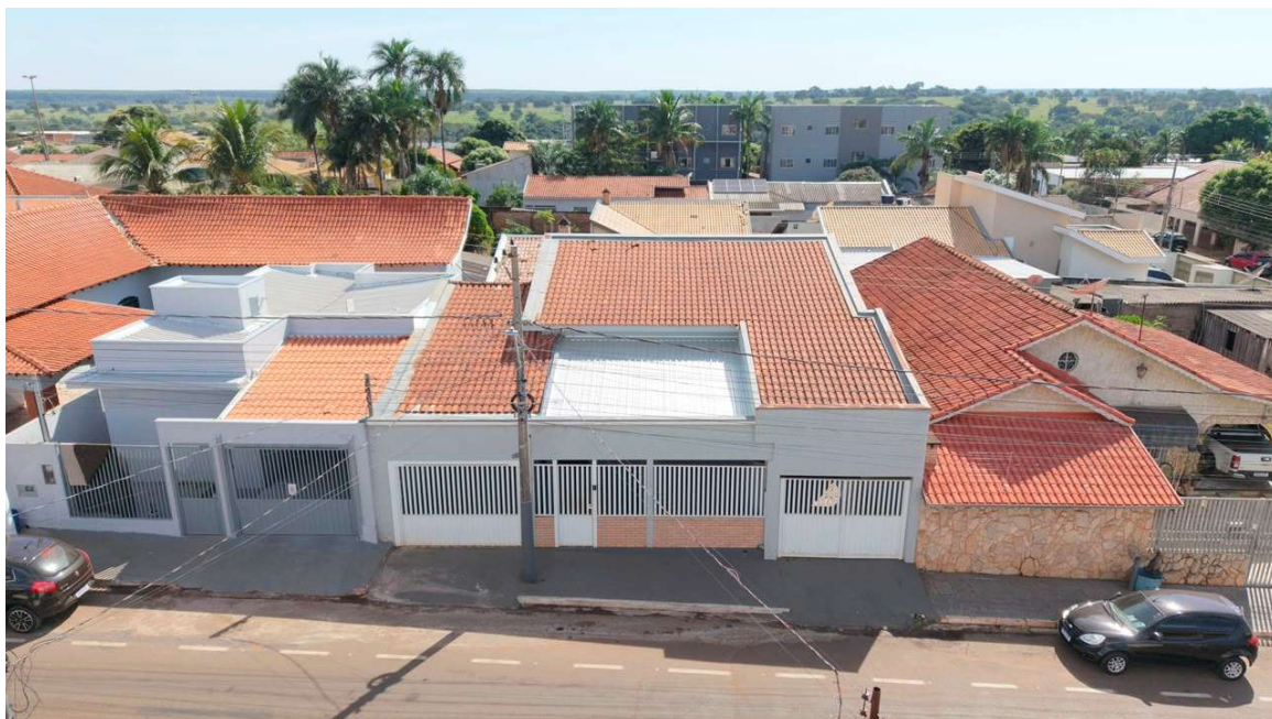
A futura Casa de Passagem Vai substituir a estrutura atual (foto), mantendo os mesmos objetivos
