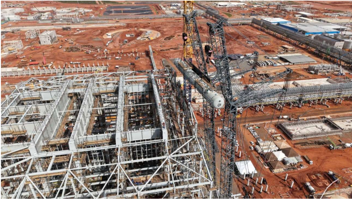
Detalhe da instalação do "coração" da nova fábrica da Arauco, com mais de 32 metros de comprimento. Foto: Divulgação/Arauco.
